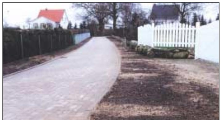
Der Grüne Weg konnte im Januar an die Gemeinde übergeben werden. Auf einer Länge von fast 220 m, wurden Schottertragschicht und Frostschuttschicht eingebracht, Anschlüsse verlegt und der gesamte Weg mit grauem Rechteckpflaster im Fischgrätenverband versehen.
