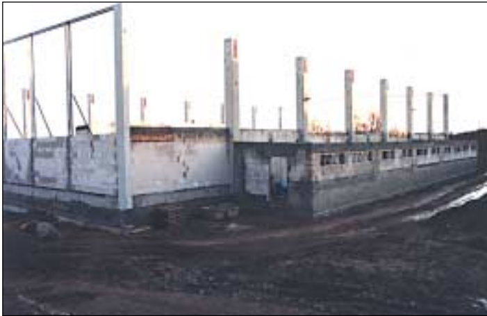
Die Baustelle im Monat Dezember 2001
