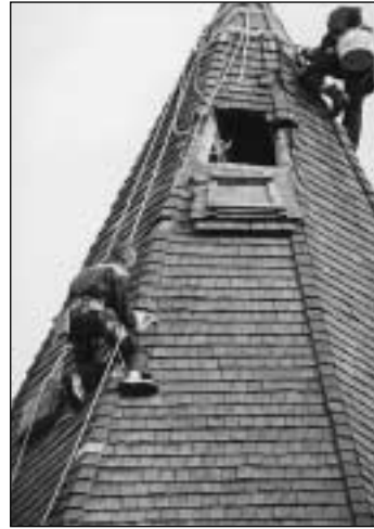
In luftiger Höhe: Erneuerung der Dachschindeln am Kirchturm
