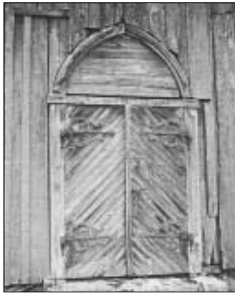
Tür an der Westseite vor der Sanierung
