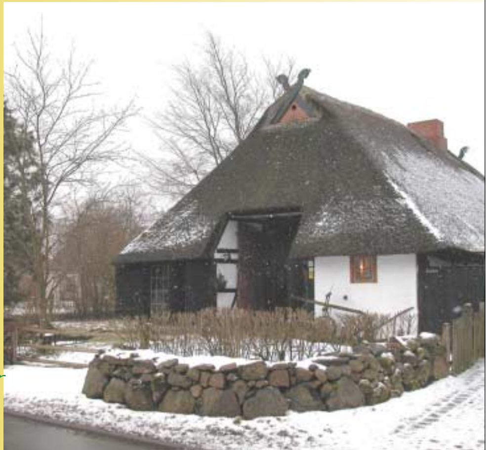
Denkmalgeschütztes Hallenhaus in der Gemeinde Warsow
