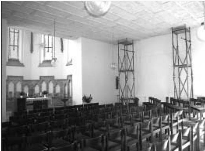
Stahlträger (r.i.B.) durchbohren die Zwischendecke und stützen das Gebälk im Dachstuhl
