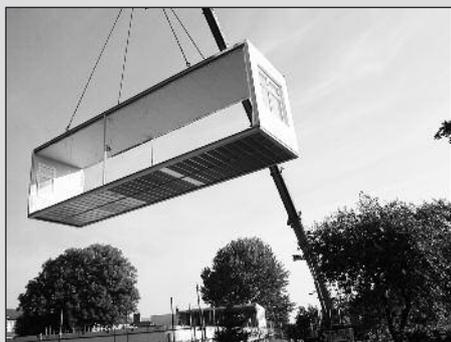
*Fliegendes Klassenzimmer: Eines von 30 Containermodulen schwebt am Kranhaken über der Grundschule ein.*
