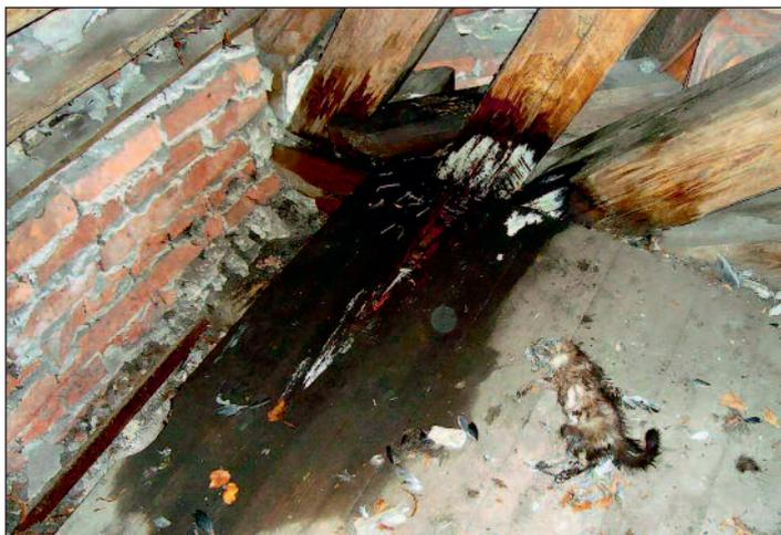
Fäulnis an den Fußpunkten der Dachsparren, hervorgerufen durch die undichte Dacheindeckung
