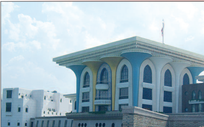
Arabischer Prunkbau: Der Palast des Sultans Qabub ibn Said
