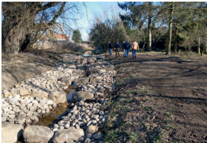
*Große Feldsteine fungieren als Riegel zur Wasserhaltung. Der Fischaufstieg bei Niedrigwasser soll stets gewährleistet sein.*
