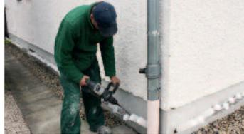
Der Fachmann bringt die Bohrkanäle im Abstand von einigen Zentimetern im Mauerwerk an.
