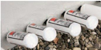
Die niederviskose und extrem kriechfähige Silikonharzlösung wird über Bohrkanäle in die Mauer injiziert.
