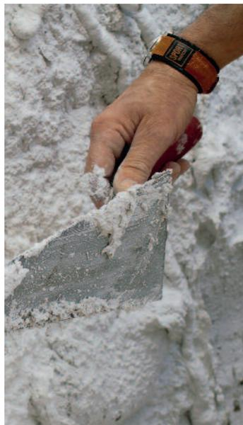
Der Mörtel wird je nach Bedarf in verschiedenen Schichtstärken von zwei bis zwölf Zentimetern aufgetragen und haftet selbst auf unebenen Untergründen.
