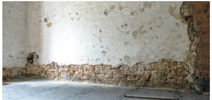
Risse, Ausblühungen und schadhafte Putzschichten: ein Fall für den mineralischen Isolier- und Entfeuchtungsputz.
